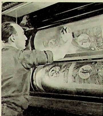
Afvaskning af offsetpladen i pressen
