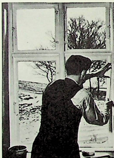
Tætning af vinduer
