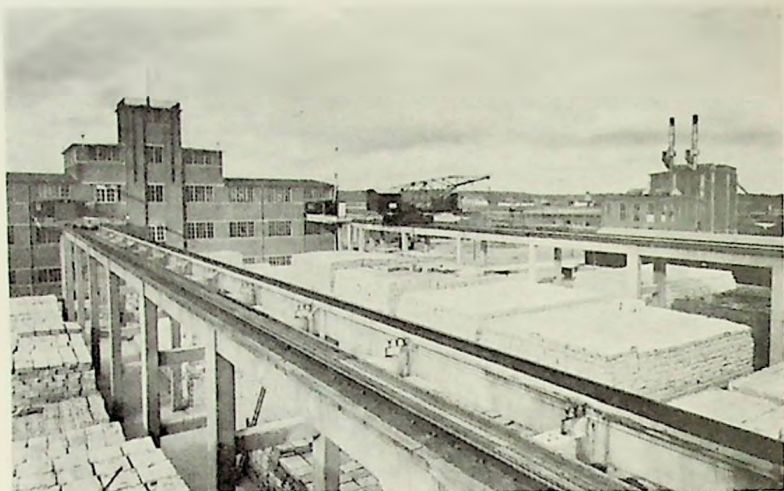
Udsnit af fabriksanlæggene og råstofpladsen på Ny Maglemølle
