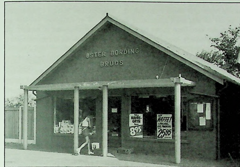
Øster Bording Brugs tilbygning i 1956
