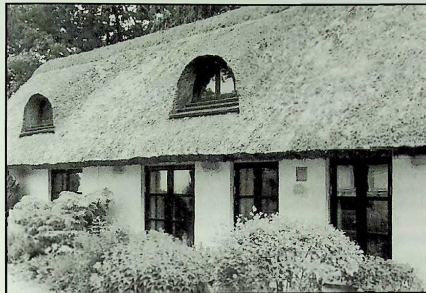
Stenholt - Øster Bordingvej 5, Balle Huse
