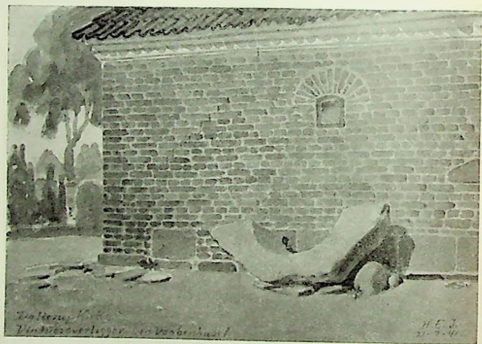
4a. Vinduesoverligger ved Vaabenhuset.
